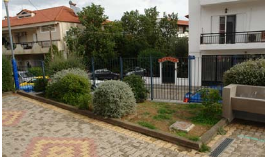
(γ) βόριο-ανατολικά από την είσοδο κτηρίου
