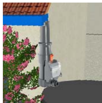
Εικόνα 7 Απλές διατάξεις φιλτραρίσματος νερού βροχής και ειδικά φίλτρα
